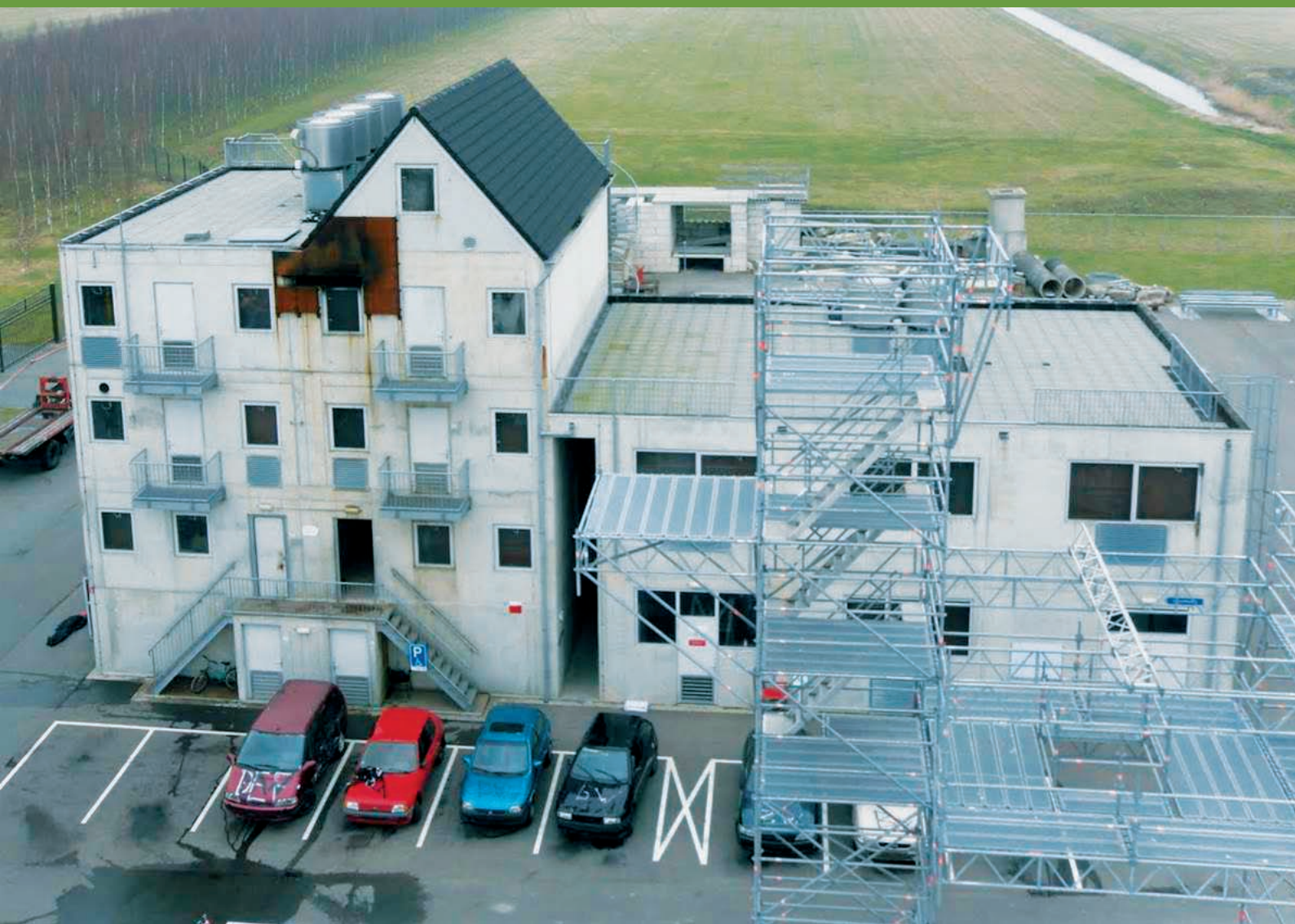
Afbeelding 1. Oefengebouw bij het Brandweer Opleidingscentrum Amsterdam-Amstelland Schiphol
