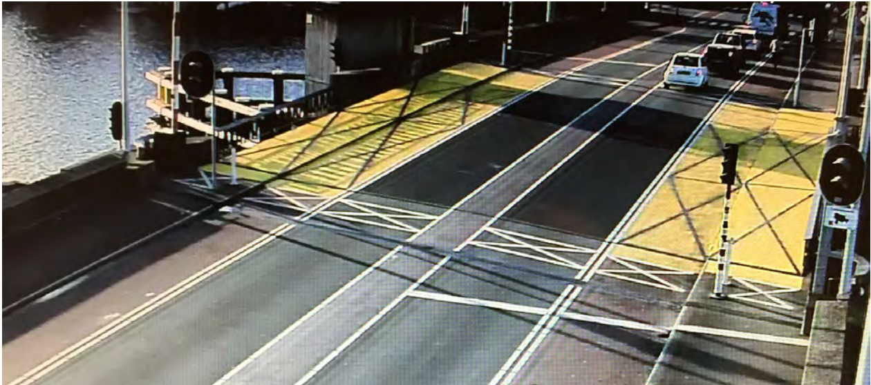
Afbeelding.2. Het herontwerp van het oorspronkelijke gele vlak op de Alexanderbrug. De markering is uitgebreid tot de bomen en het beweegbare deel is gemarkeerd door zwarte kruisen. Deze brug kent twee delen die openen.
