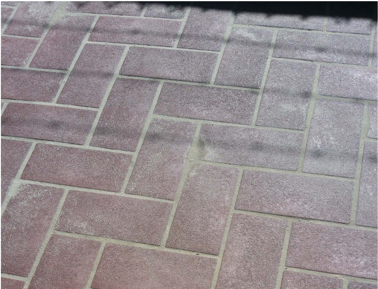
Afbeelding 2. Het eindproduct compleet; straat met kunststof bestrating.
